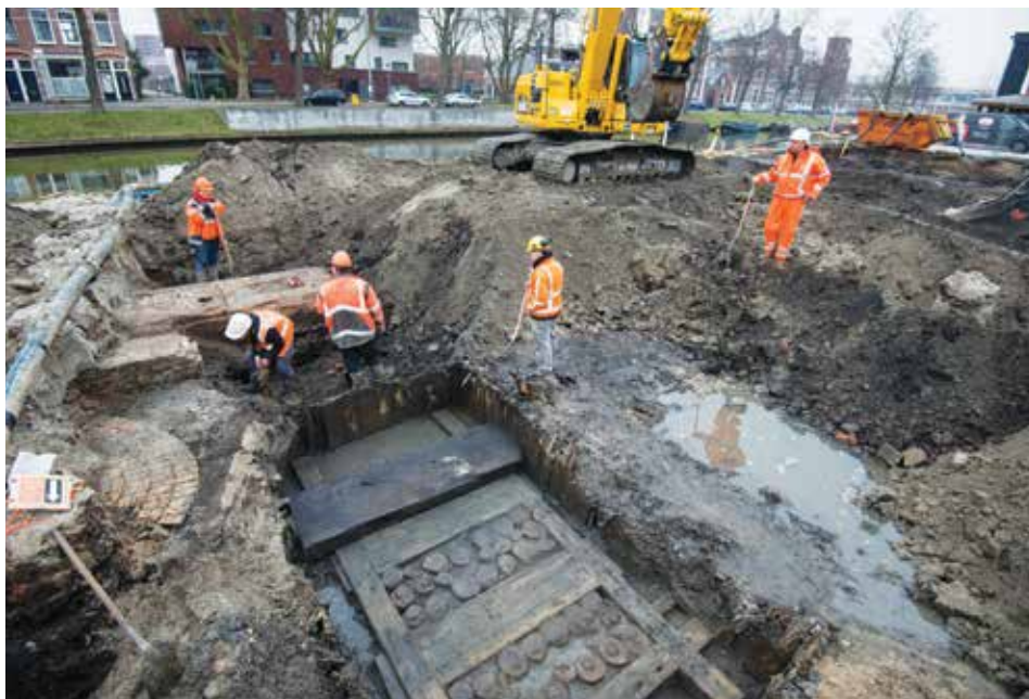
Het fundament langs de Vaartsche Rijn..(foto: Robert Oosterbroek / DUIC)
